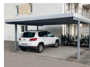
Zastřešení parkovacích míst
